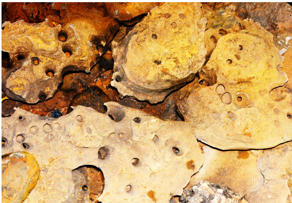
Figure 11. Tham Hong San, formes de corrosion au début du Grand Toboggan. Les petits trous circulaires sont dus aux gouttes continues du plafond pendant la saison humide. Photographie par Liviu Vălenaș, 2019.
